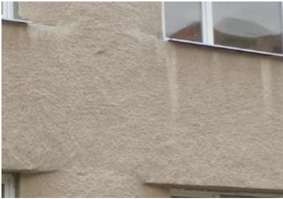
Снимка 7 Неизолирана фасадна стена
