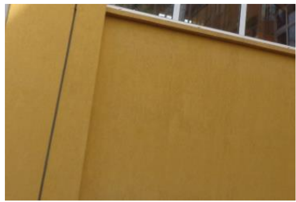
Снимка 10 Топлоизолирана фасадна стена
