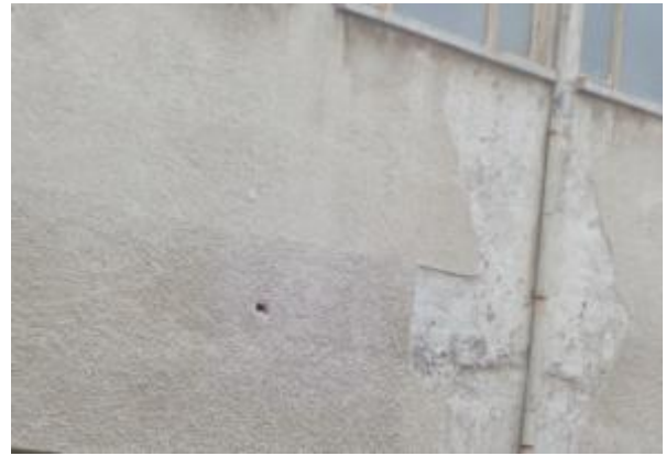
Снимка 8 Неизолирана фасадна стена
